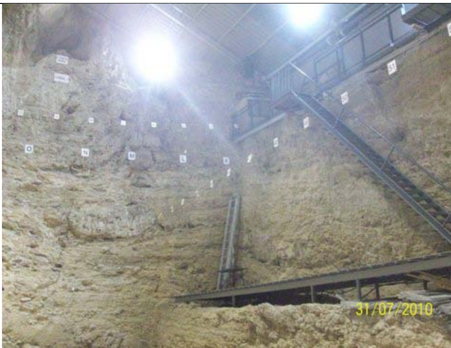
Excavación vista des arriba
