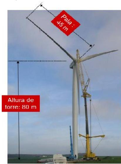
Ilustración 14: Máquinas eólicas y sus componentes
