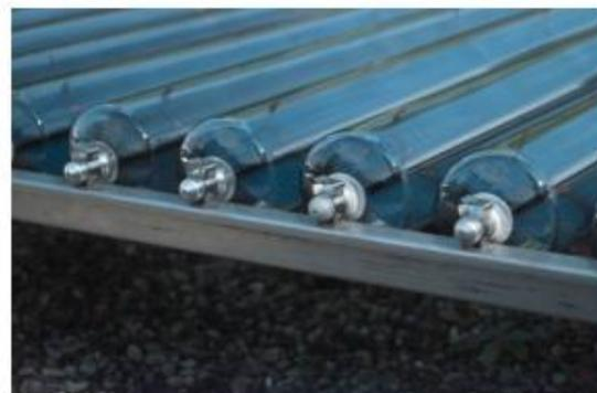
Ilustración 4: Captadores de vacío
